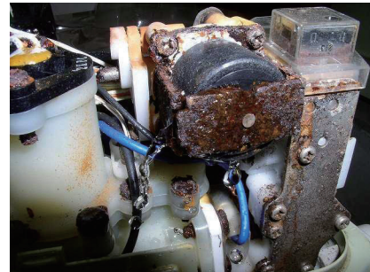
洗剤から発生したガスによる金属部品の腐食
